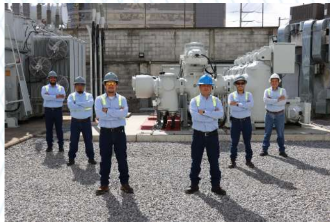
Amp. Subestación Ciudad Vieja 69 kV
